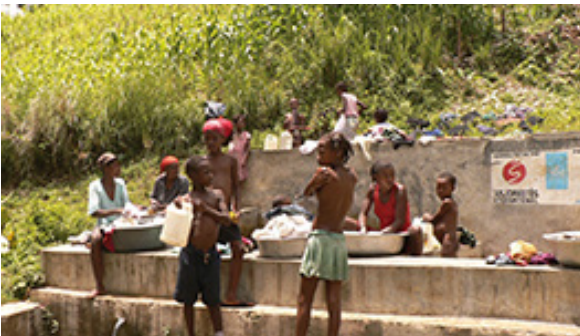
RÉHABILITATION DE CAPTAGE DE SOURCE PETIT GOÂVE, HAÏTI
