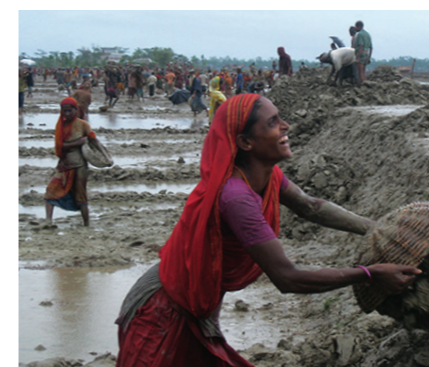
Construction d'une digue au Bangladesh.
